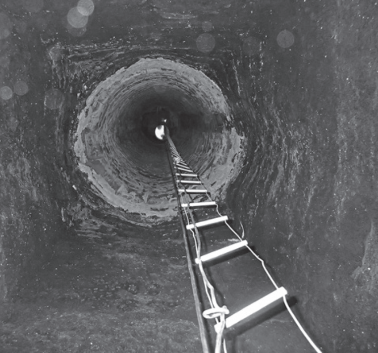
AFBEELDING 3: Zicht naar boven al staande op de huidige bodem van de waterput. Het gedeelte in de mergel is vierkant en zwart gekleurd. Het gedeelte met wandbekleding is rond en heeft de kleur van mergel.
